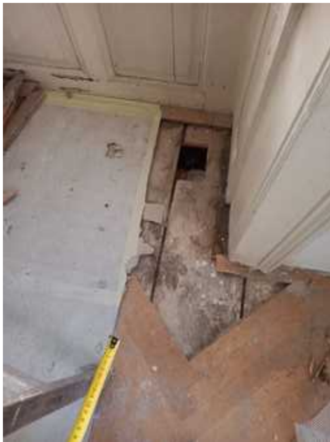
5. kép – roncsolásos kutatás 1. emelet, bal erkély helyzetében
