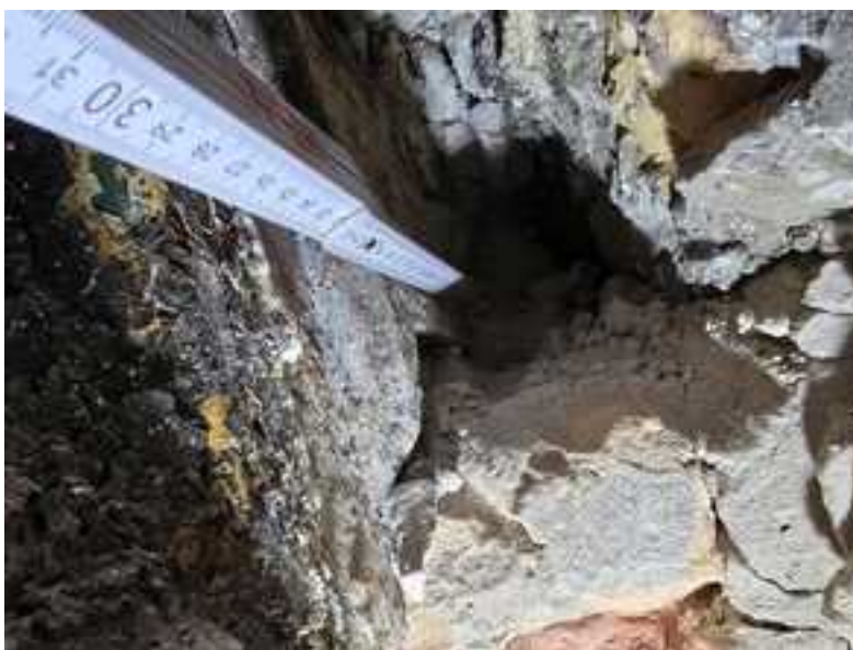
2. kép – 1. emeleti vaskonzol felső szegmens bekötése falba, hátrakötésnek nincsen nyoma (készítette: Nagy Statika Kft.)
