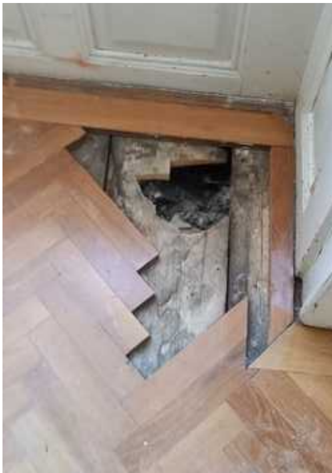
7. kép – roncsolásos kutatás 2. emelet, bal erkély helyzetében
