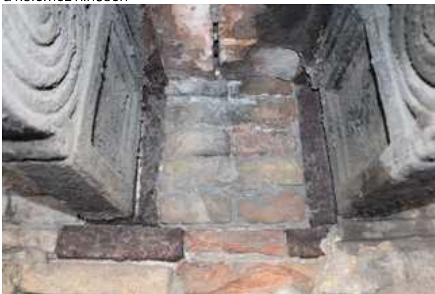
6. kép – 2. emeleti középső konzolok esetében 1-1, 24 cm széles vaslemez alátét
